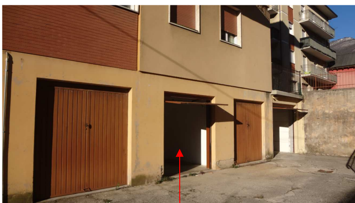
ACCESSO AL BOX – GARAGE (SUB 13)
