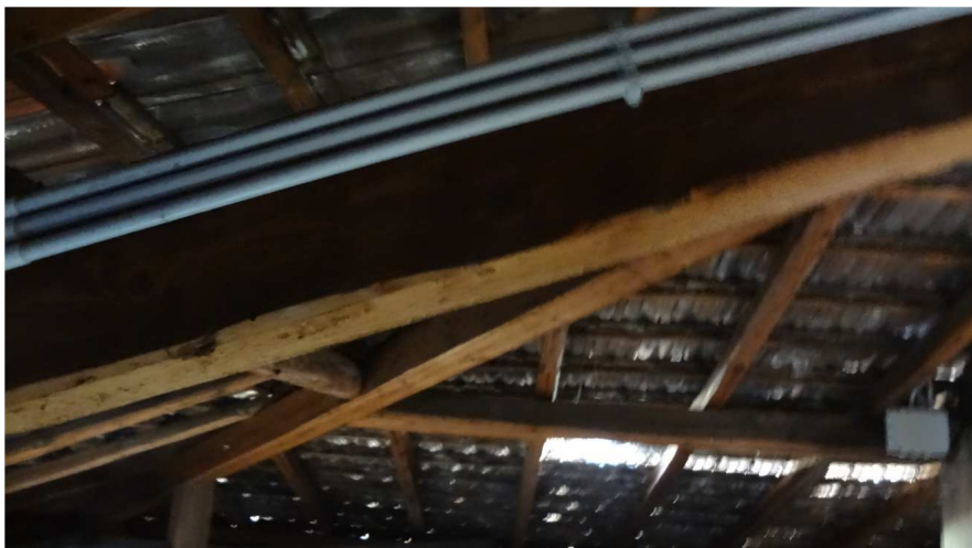
PARTICOLARE COPERTURA VISTA DAL SOTTOTETTO
