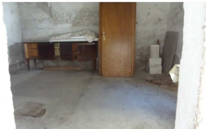
AVVOLTO AL PIANO TERRA
